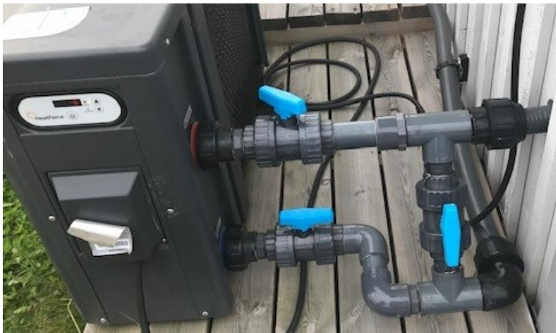
Bypass installation enligt alternativ 1
