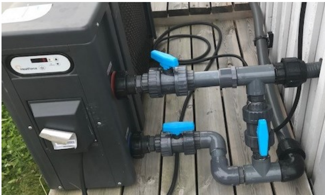
Bypass installation enligt alternativ 1
